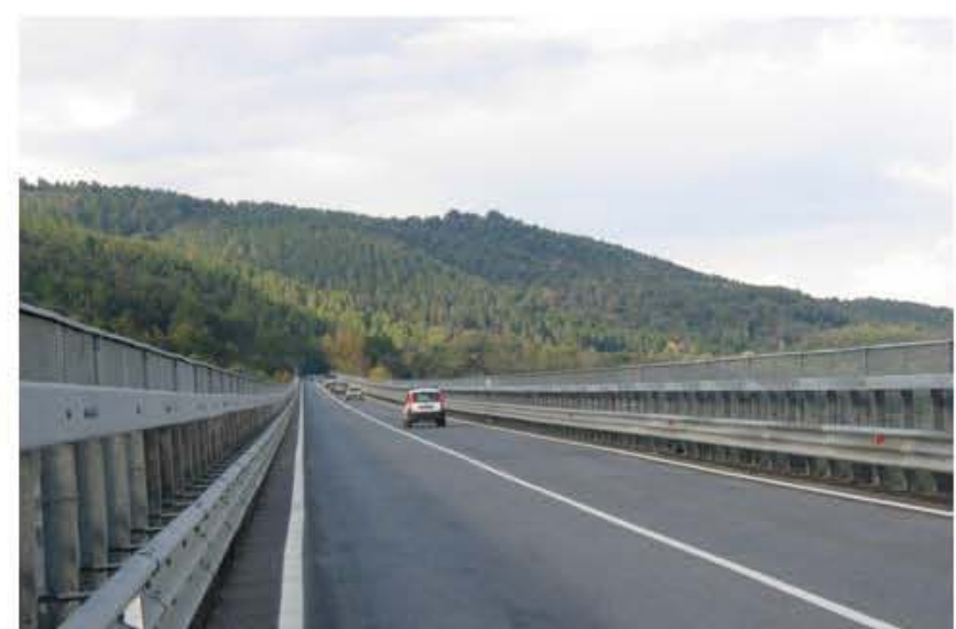
Il viadotto sul Farma della SR.223 che collega la provincia di Siena con Grosseto.
